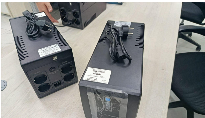
Рис. 7 - Установка и подключение новых ИБП
