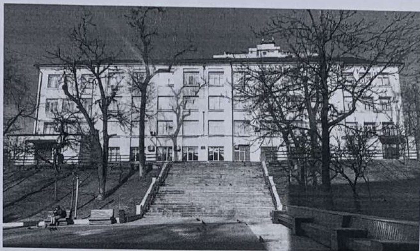
Рис 4. Фасад здания МБОУ «Центр образования №28 с углубленным изучением иностранных языков г. Владивостока»
