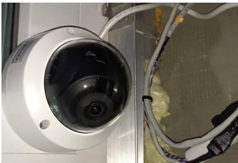
Рисунок 3 – Монтаж новой камеры
