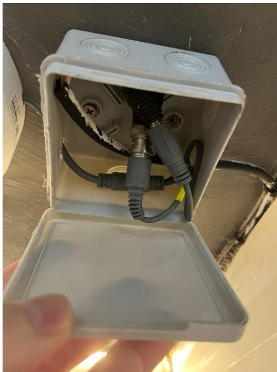
Рисунок 2 – Коммутация камеры в офисе
