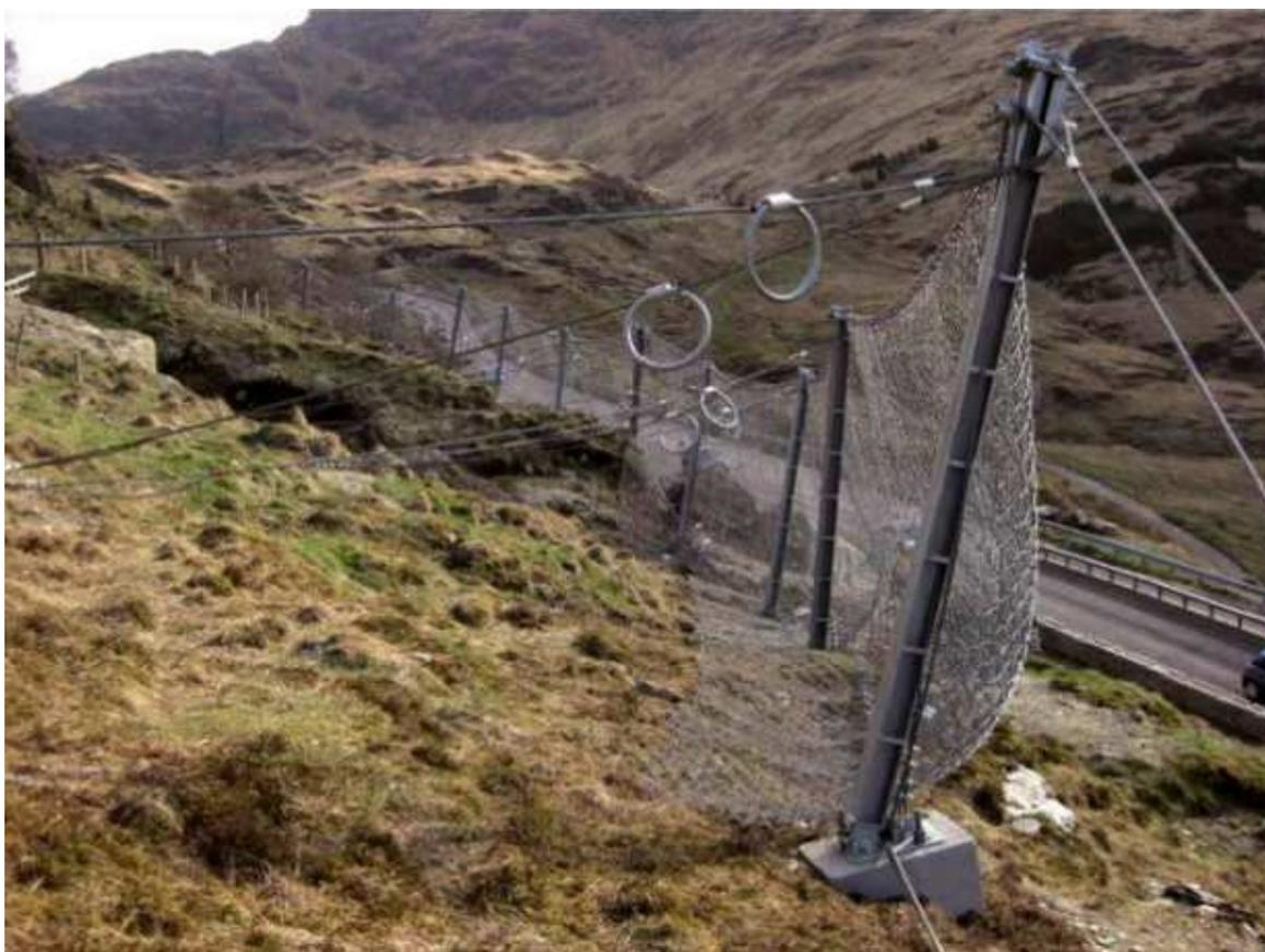
Рис. 2. Общий вид гибкого противокамненного барьера
