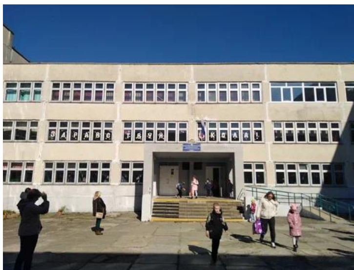
Рисунок А. 1 – Фасад здания. МБОУ СОШ №74
