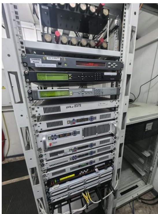
Рисунок 14 - Передатчик «Полярис ТВЦ-50» в Раздольном
