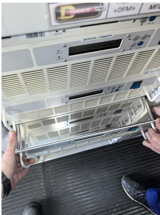
Рисунок 41 - Демонтаж усилителя из стойки
