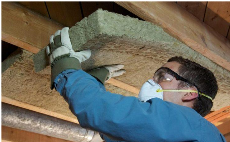
Рис. 2. Установка ваты
