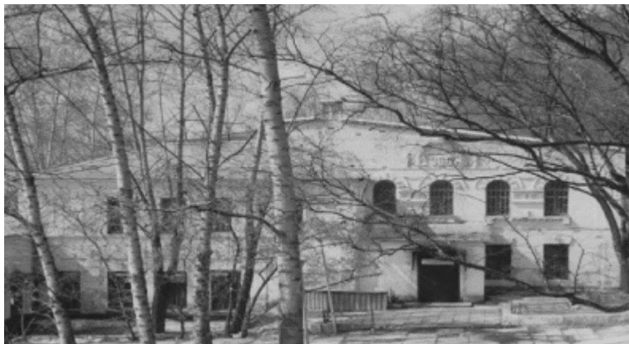
Рис. 2. Здание первой городской электростанции
