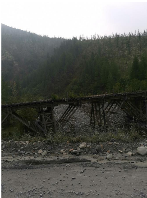
Рис. 14. На трассе Якутск – Магадан ремонтируют дороги по отдельным участкам и строят новые мосты. На фотографии старый мост
